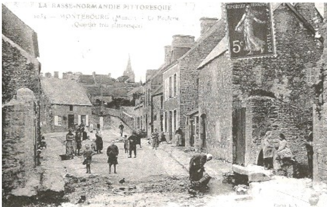
Vue du passage à gué de la Foulerie entre Saint Floxel et Montebourg (photographie de 1901). Les lieux sont restés en l'état jusqu'en 1972 date de construction de l'actuel pont
